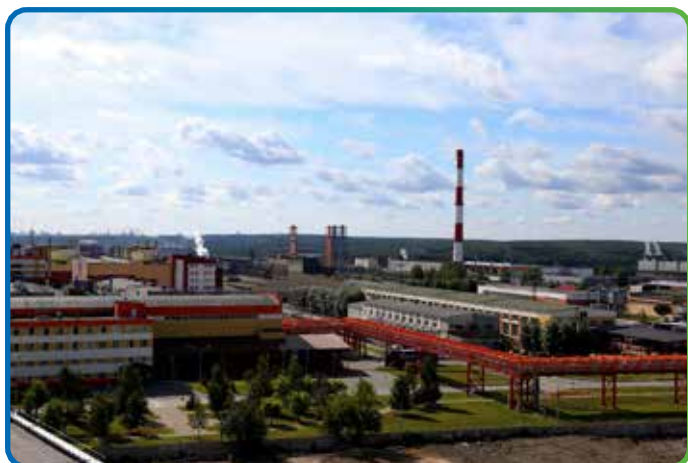
Энергоцех Уралэлектромедь, г. Верхняя Пышма
